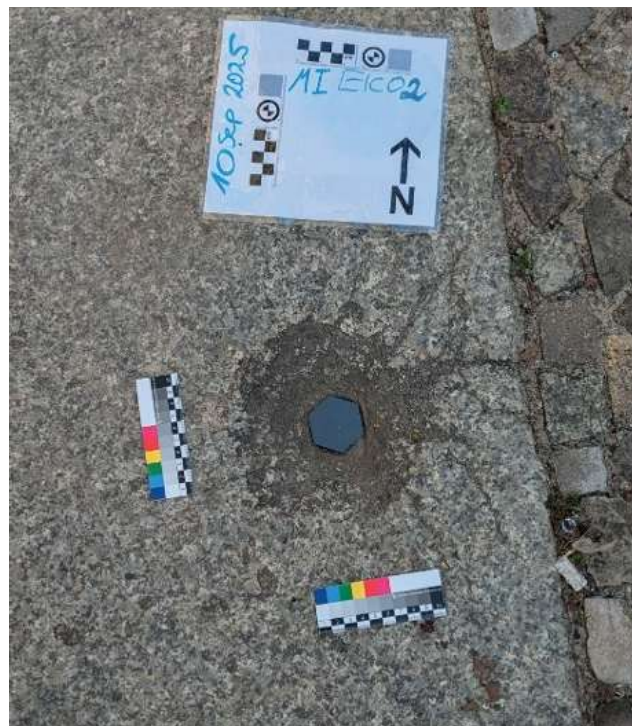
Krater mit eingepasster Schablone des sechseckigen Querschnitts einer Stabbrandbombe. Die übereinstimmenden Anlehnungskanten belegen, dass dieser Schaden von einer Stabbrandbombe verursacht wurde.
