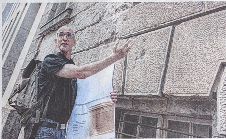
Hans Greiner zeigt beim „Tag des offenen Denkmals“ Kriegsschäden in einer Fassade.
